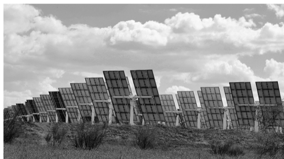
Una imagen de las instalaciones de la PSA.
