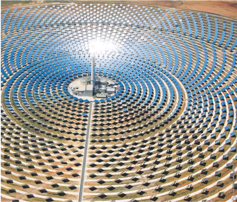
Una planta de Sevilla, referencia mundial Izquierda, la central Gemasolar (Sevilla) fue pionera en producir electricidad durante 24 horas ininterrumpidas a partir del calor del sol
