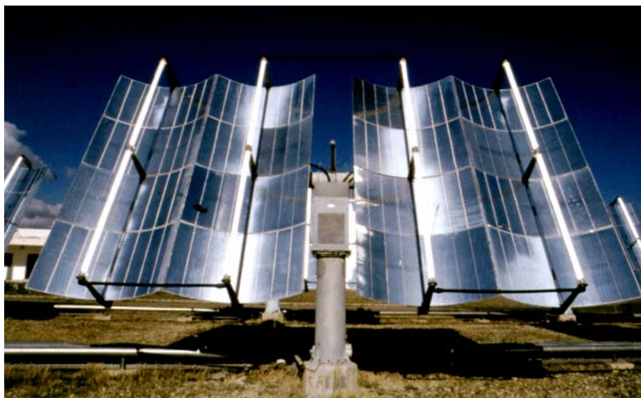
Figura 1.3.11. Colector cilindro-parabólico con seguimiento en dos ejes instalado en la PSA.
