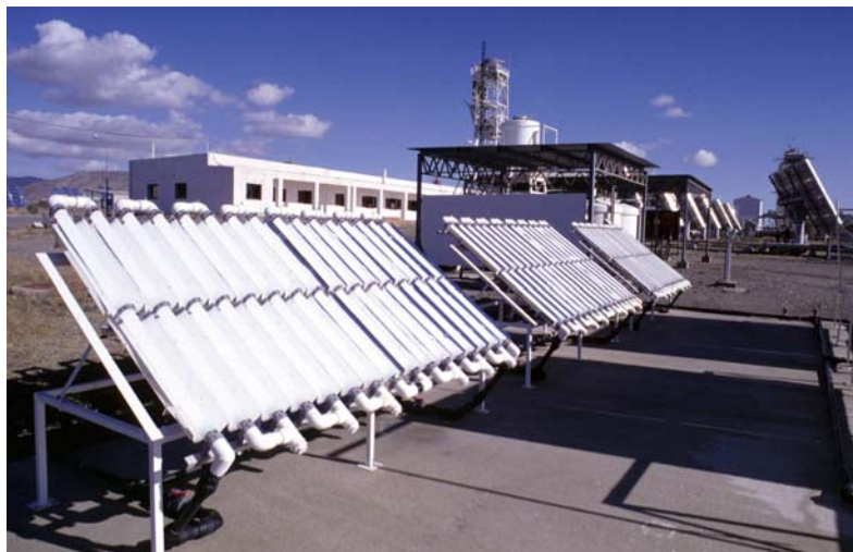
Figura 2.1.3. Vista general de la planta piloto de CPCs para aplicaciones fotocatalíticas de la PSA.
