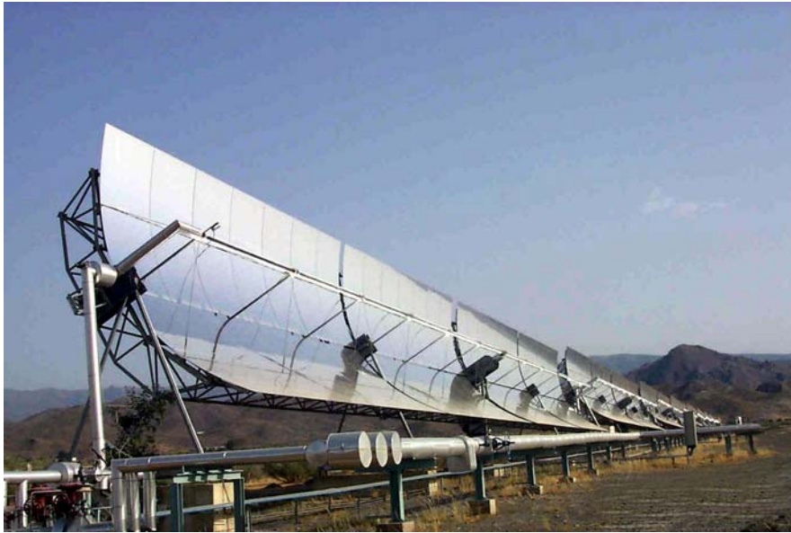
Figura 1.3.7. Colector solar de media concentración instalado en la Plataforma Solar de Almería.
