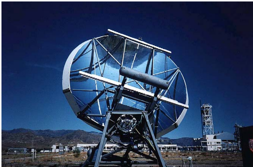
Figura 1.3.8. Colector solar de alta concentración instalado en la PSA.
