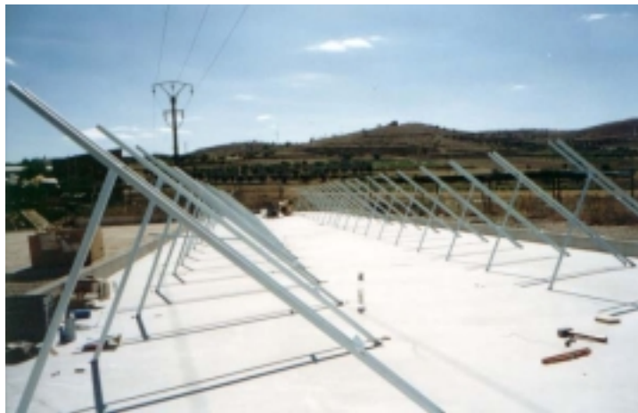
Fig. 7.23.- Instalación de estructura soporte del campo de colectores solares
