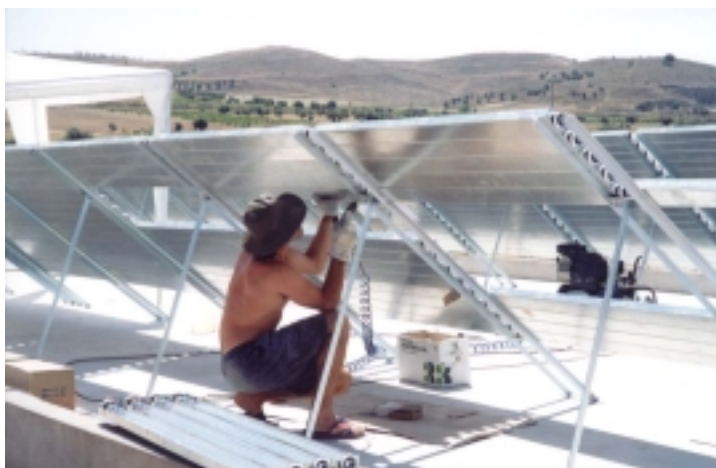
Fig. 7.24.- Acoplamiento de módulos CPC sobre la estructura soporte previamente instalada
