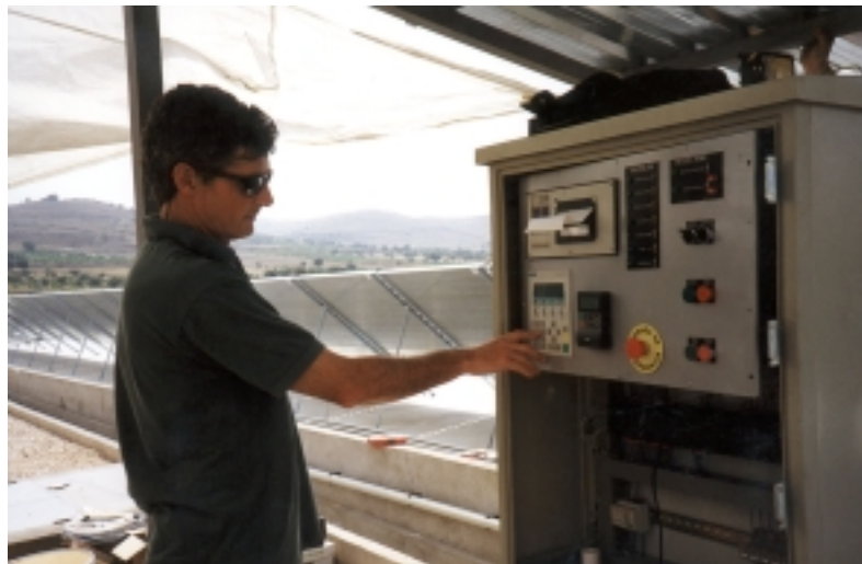
Fig. 7.29.- Comprobación y ensayo del PLC y del cuadro de control de la planta
