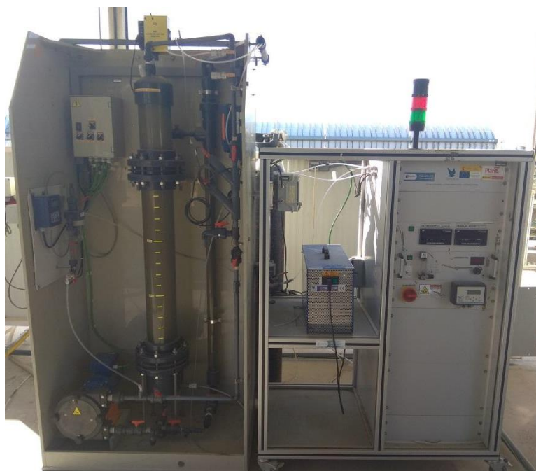
Figura III.26. Planta piloto de ozonización ubicada en la PSA.
