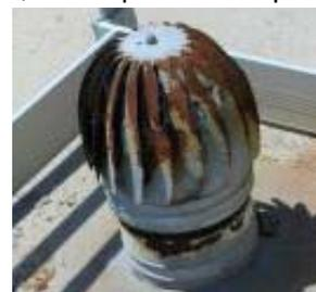
Figura 1.1. Corrosión por H<sub>2</sub>S
