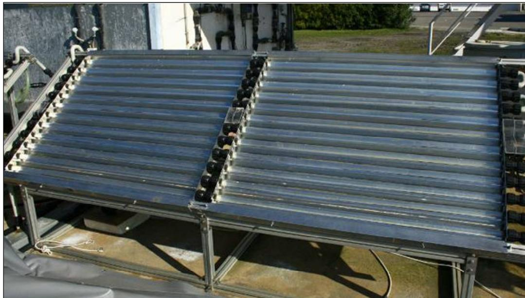
**Figura 1.15** CPC utilizado para aplicaciones solares de fotocatalisis, instalado en la PSA.
