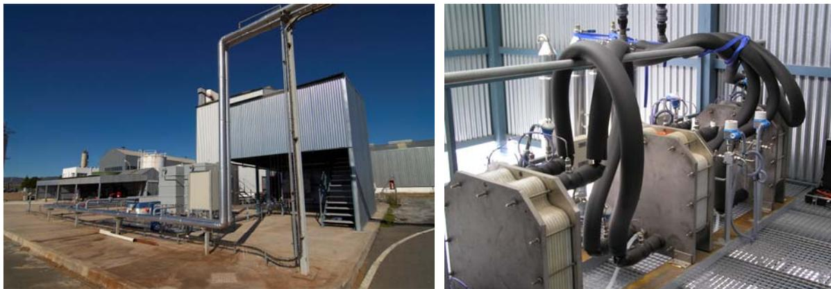
Figura 4.18 Vista general de las instalaciones de la planta piloto MEDESOL-1 (izq.); Detalle de los tres módulos de destilación por membrana (dcha.)
