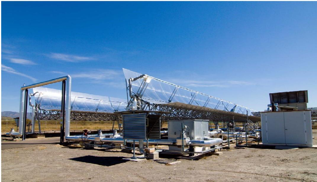
Figura 2.9 Vista del lazo de ensayos para fluidos innovadores en operación.
