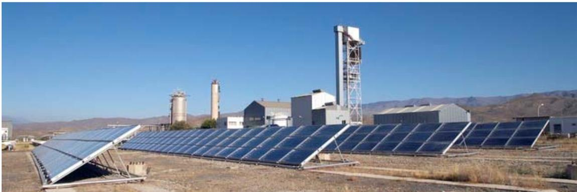
Figura 2.18 Campo de captadores solares estáticos (500 m<sup>2</sup>) de la planta SOL-14
