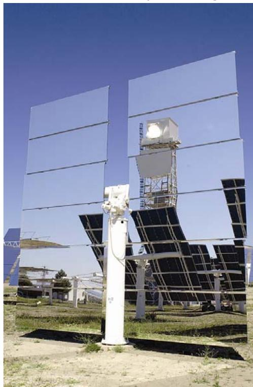
Figura 2.3 Un helióstato del campo CRS con vista reflejada de la torre
