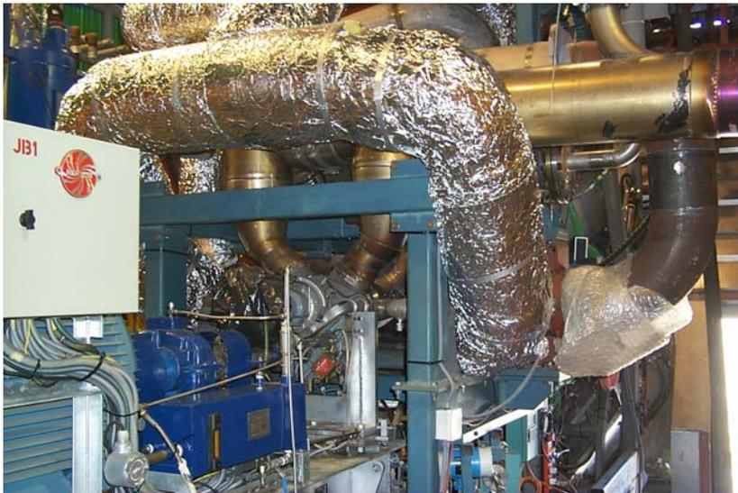
Figura 3.15 Turbina "Ormat" en el nivel de 60 m en la torre CESA-1
