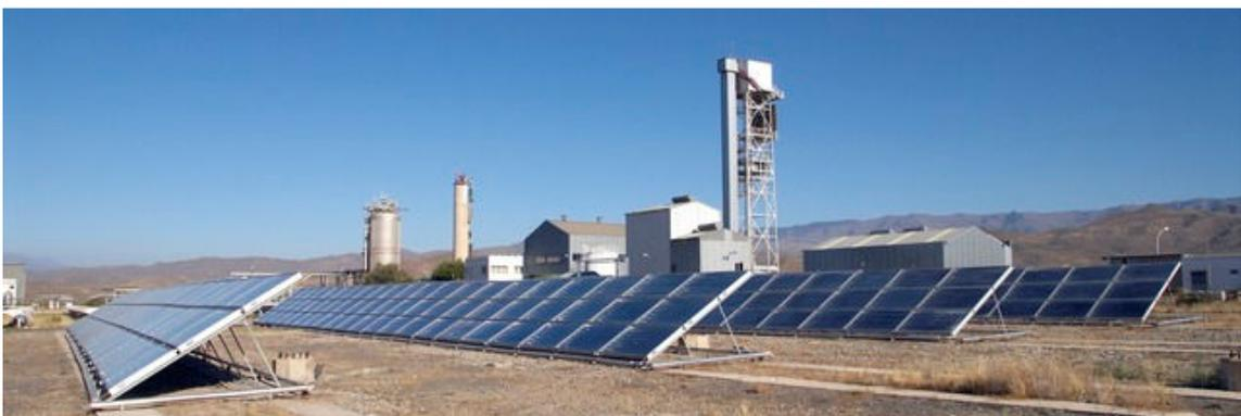
Figura 2.15 Campo de captadores solares estáticos (500 m<sup>2</sup>) de la planta SOL-14
