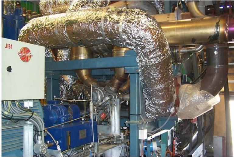
Figura 3.17 Turbina "Ormat" en el nivel de 60 m en la torre CESA-1
