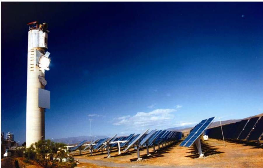
Figura 2.2 Vista lateral de la instalación CESA-I con las filas de helióstatos enfocando al nivel intermedio de ensayos (60 m.)
