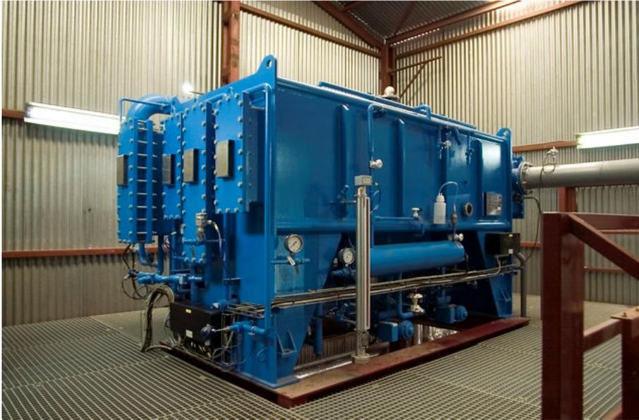
Figura 4.14 Bomba de calor por absorción (LiBr-H<sub>2</sub>O) de doble efecto
