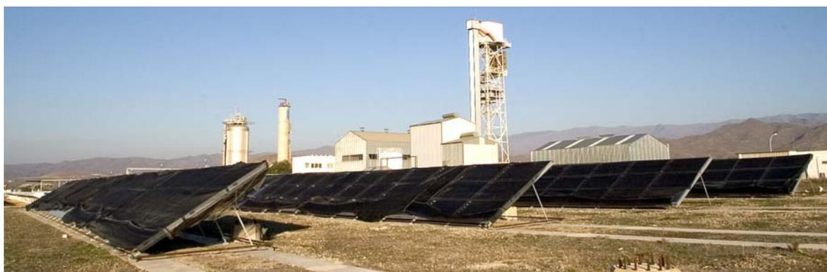
**Figura 82. Campo de colectores solares estáticos de tipo CPC de la Planta AQUASOL**
