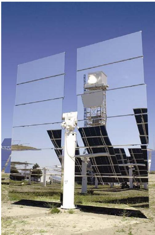
**Figura 9. Un helióstato del campo CRS con vista reflejada de la torre**
