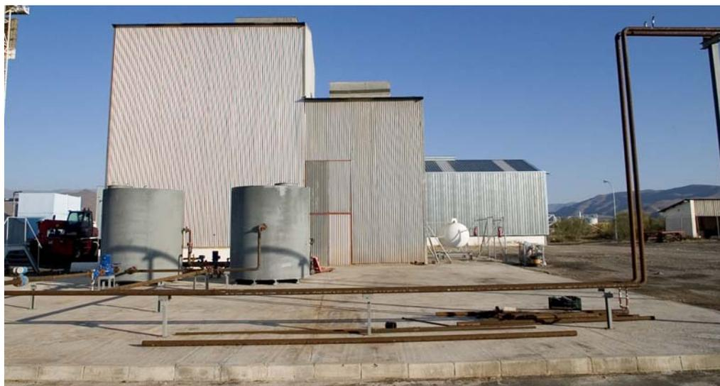
**Figura 81. Vista frontal del edificio que alberga la planta de destilación MED, con los dos tanques de almacenamiento térmico, el depósito de gas propano (derecha) y vista parcial de la conexión hidráulica.**
