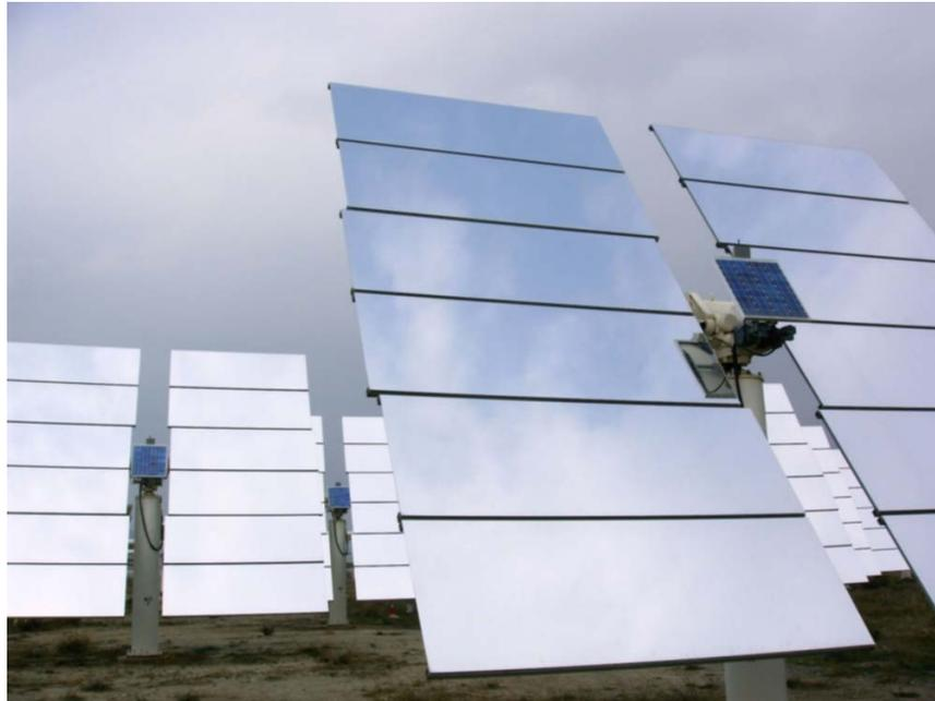
Figura 45. Vista frontal parcial del campo de helióstatos CRS de la PSA, con un total de 92 unidades enteramente autónomas y controladas por radio. En el centro del helióstato se observa colocado sobre el pedestal, el panel FV de alimentación al sistema de control y la antena de comunicación con el control central.
