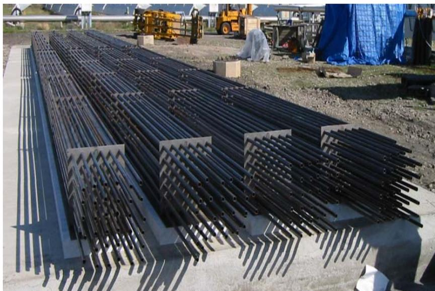
Figura 14. Haces tubulares correspondientes a los módulos de almacenamiento
