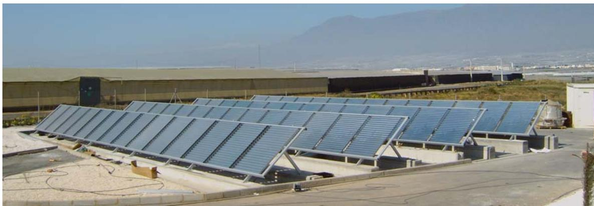
Figura 74. Vista del campo de colectores CPC (150 m<sup>2</sup>) instalados en planta de reciclaje de residuos plásticos en La Mojonera (Almería)
