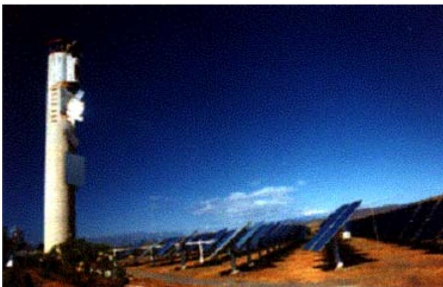
Figura 8. Vista lateral de la instalación CESA-I con las filas de helióstatos enfocando al nivel intermedio de ensayos (60 m.)
