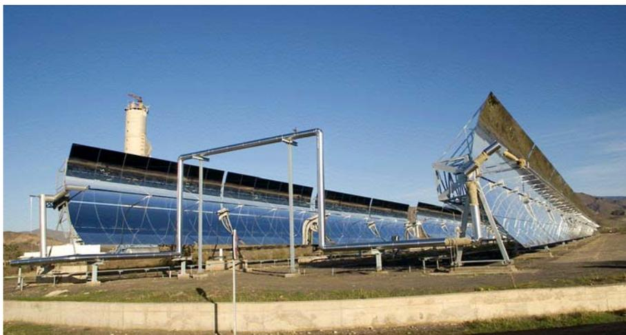
Figura 50 Vista de la interconexión en "U" de los dos nuevos colectores con la fila instalada en 1998.
