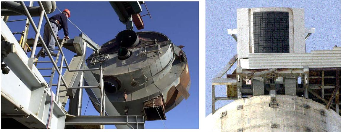
**Figura 40 Retirada del receptor TSA de absorbedor metálico en marzo de 2003 (Izquierda) y vista frontal del nuevo receptor Solair-3000 en la torre CESA-I.**
