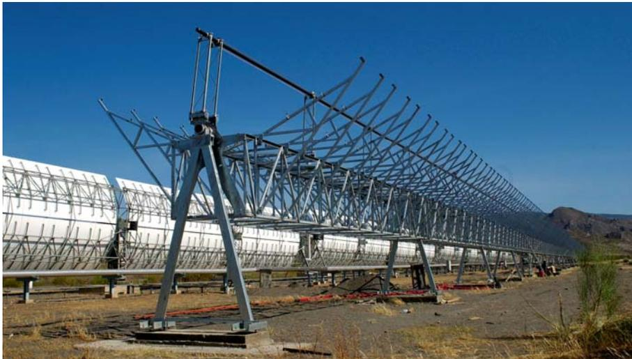
Figura 49 vista de las estructuras metálicas de los dos nuevos colectores instalados en la planta DISS.
