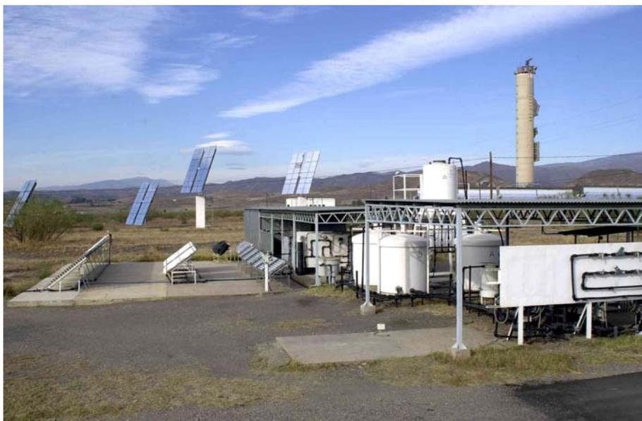
**Figura 25 Vista general de las instalaciones para aplicaciones de Fotoquímica Solar basadas en colectores CPC con el nuevo colector en primer plano**
