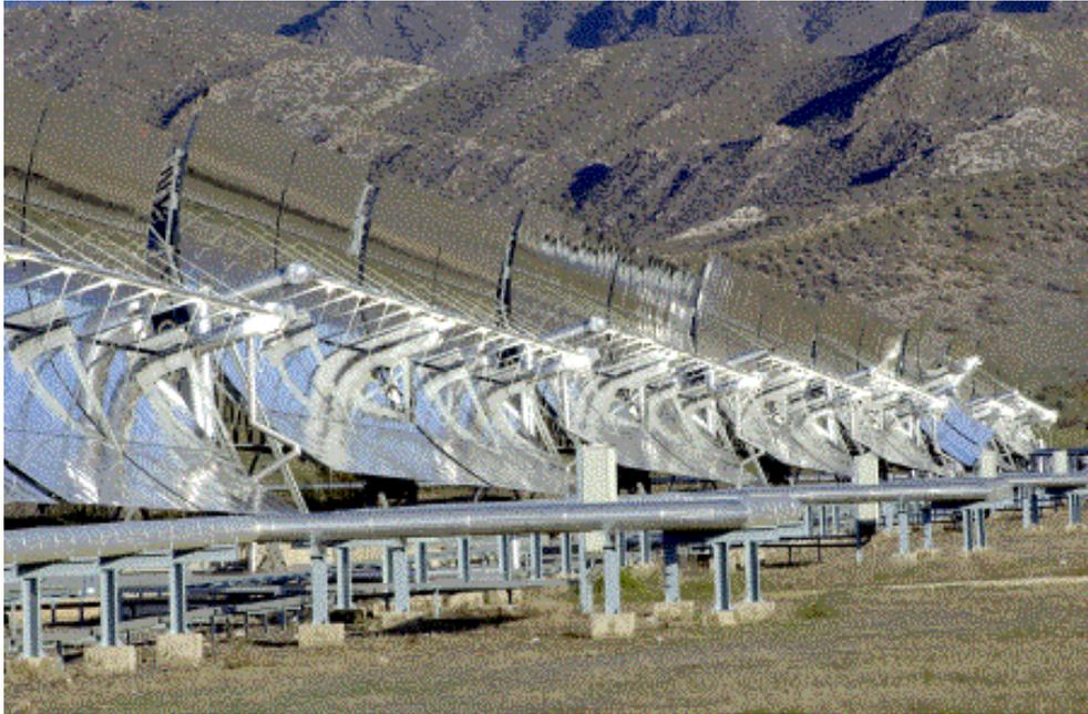
Figura 11. Vista del campo solar del lazo DISS en funcionamiento
