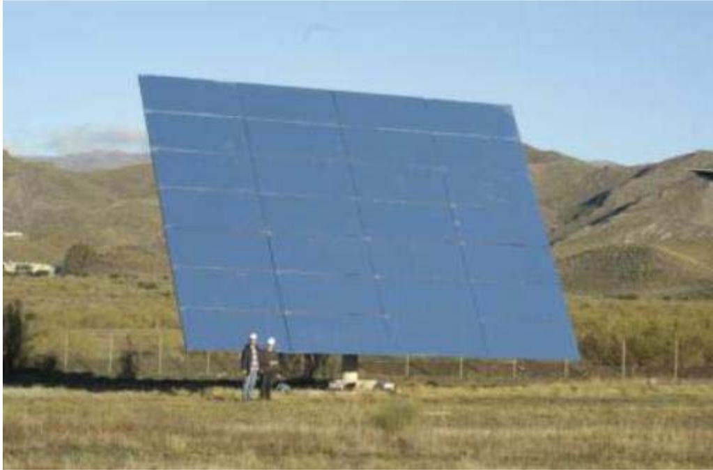
**Figura 32.** Vista delantera del heliostato Sanlúcar-120 instalado en la PSA por la empresa SOLUCAR a finales de 2002.
