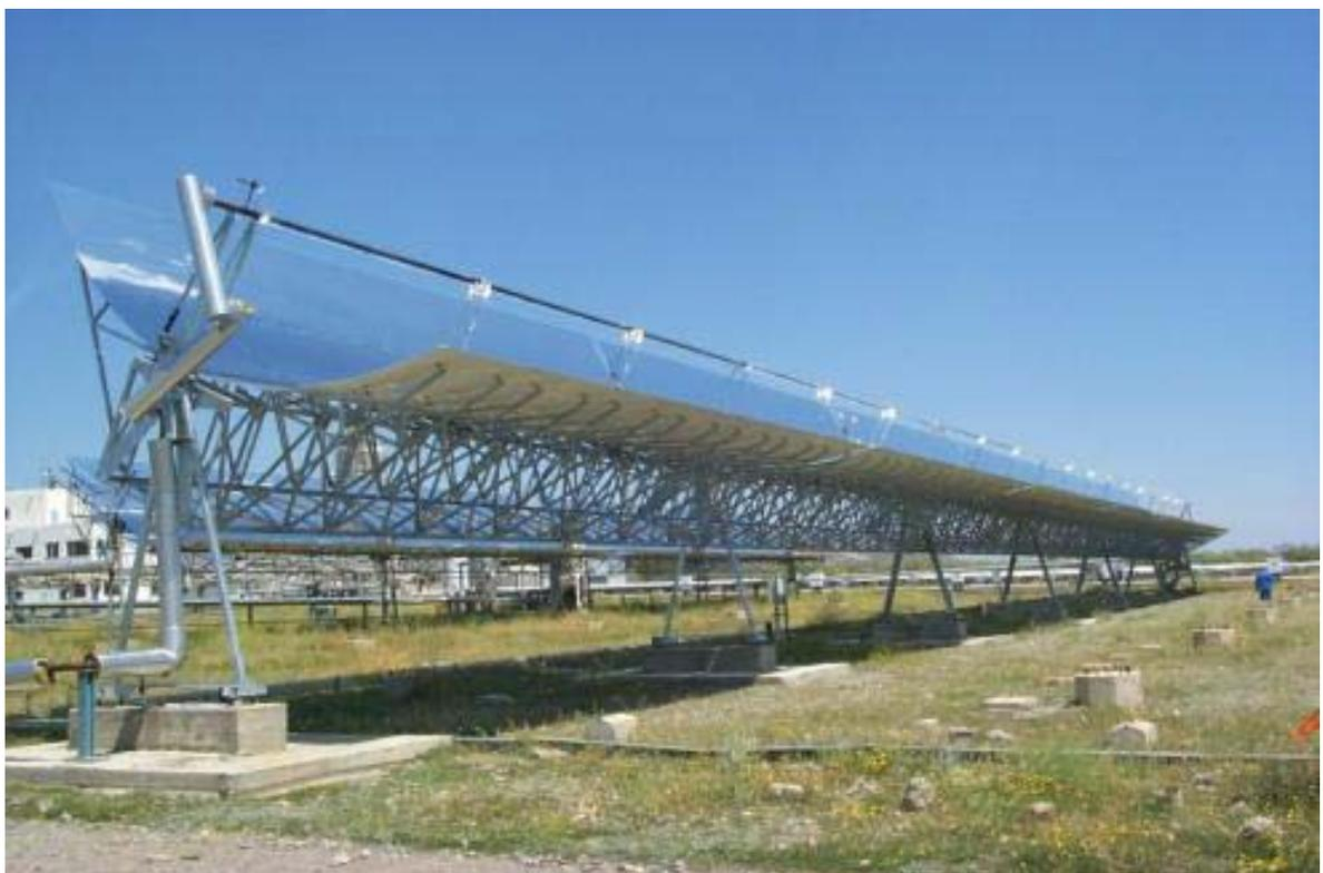
Figura 39. Vista del prototipo de colector EUROTROUGH instalado en la PSA
