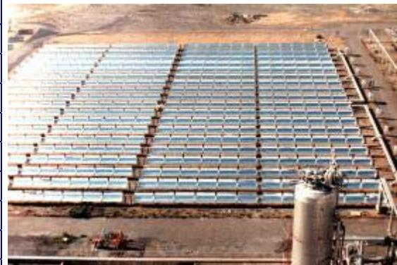
Figura 15. Especificaciones técnicas de la planta de Desalación Solar SOL-14 de la PSA y vista aérea de la misma: campo Acurex, tanque de almacenamiento térmico (arriba izquierda) y planta MED (arriba derecha)
