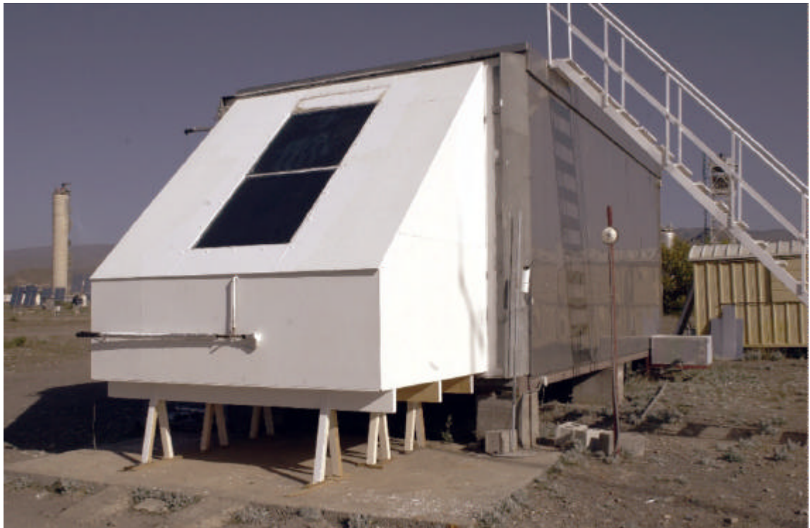
Vista de ensayo de colector solar utilizado como cerramiento inclinado
