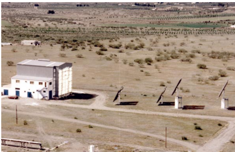
Vista exterior del Horno Solar de la PSA
