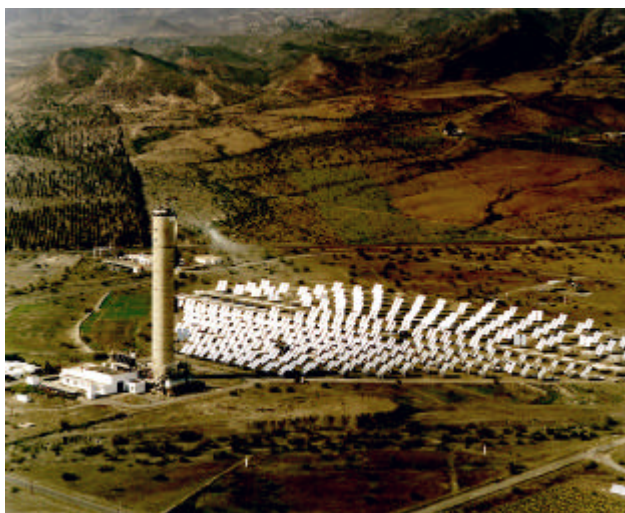
Vista aérea de la instalación CESA-I
