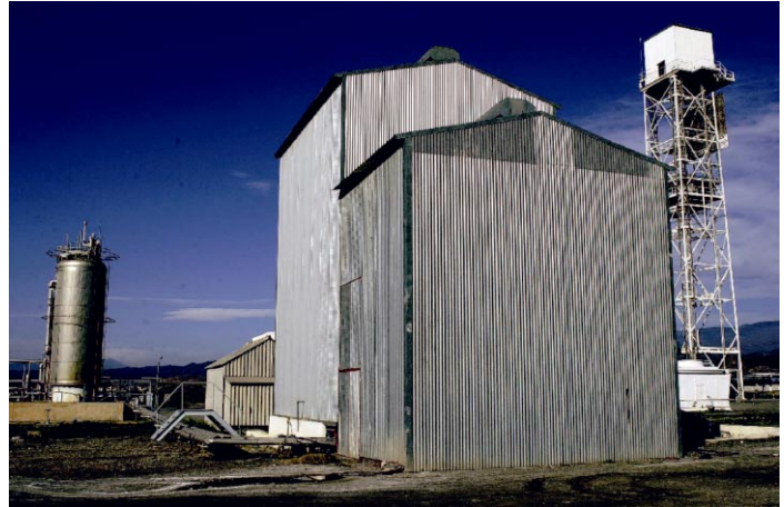
Vista exterior de la planta con el tanque termoclino de almacenamiento térmico al fondo (arriba)
