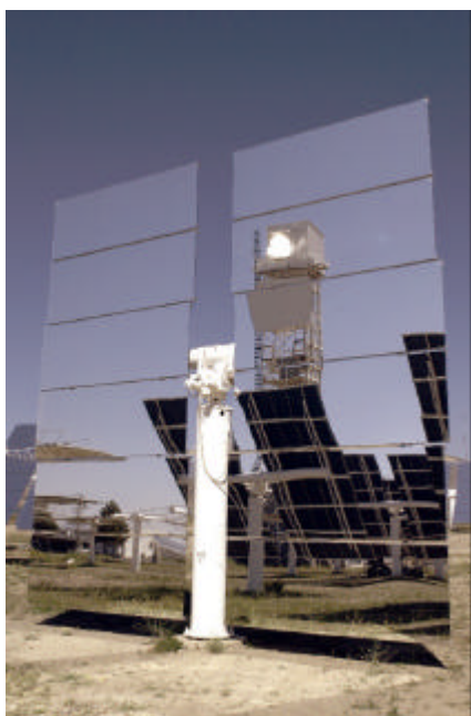
Un heliostato del campo CRS con vista reflejada de la torre
