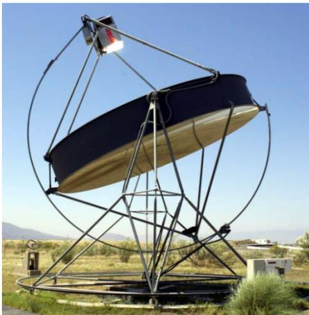
Figura 34. Vista del disco parabólico DISTAL- II con el motor original Stirling.
