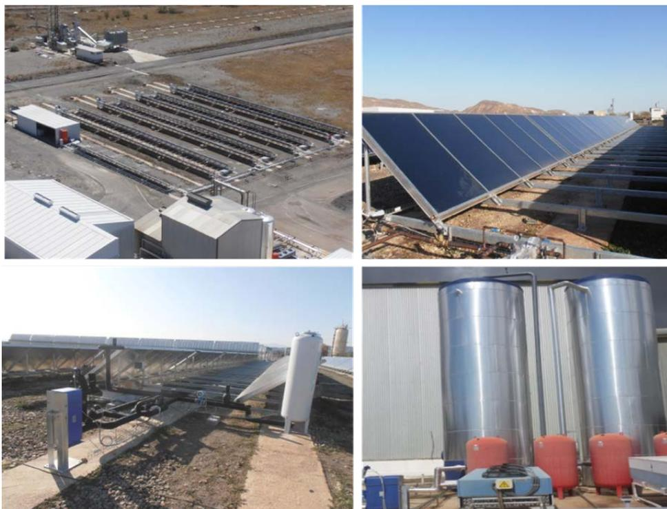
Figura 37. El campo solar de 606-m<sup>2</sup> con captadores de placa plana de gran apertura (AQUASOL-II).
